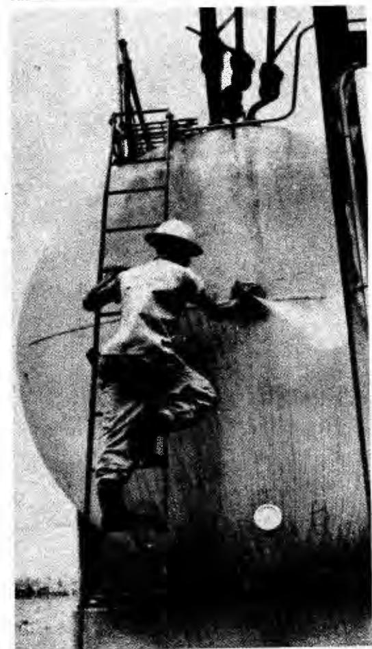
ESTE TANQUE CONTIENE L.P.G., MEZCLA DE PROPANO Y RUTANO QUE SE UTILIZA EN UNA FASE DEL PROCESO
